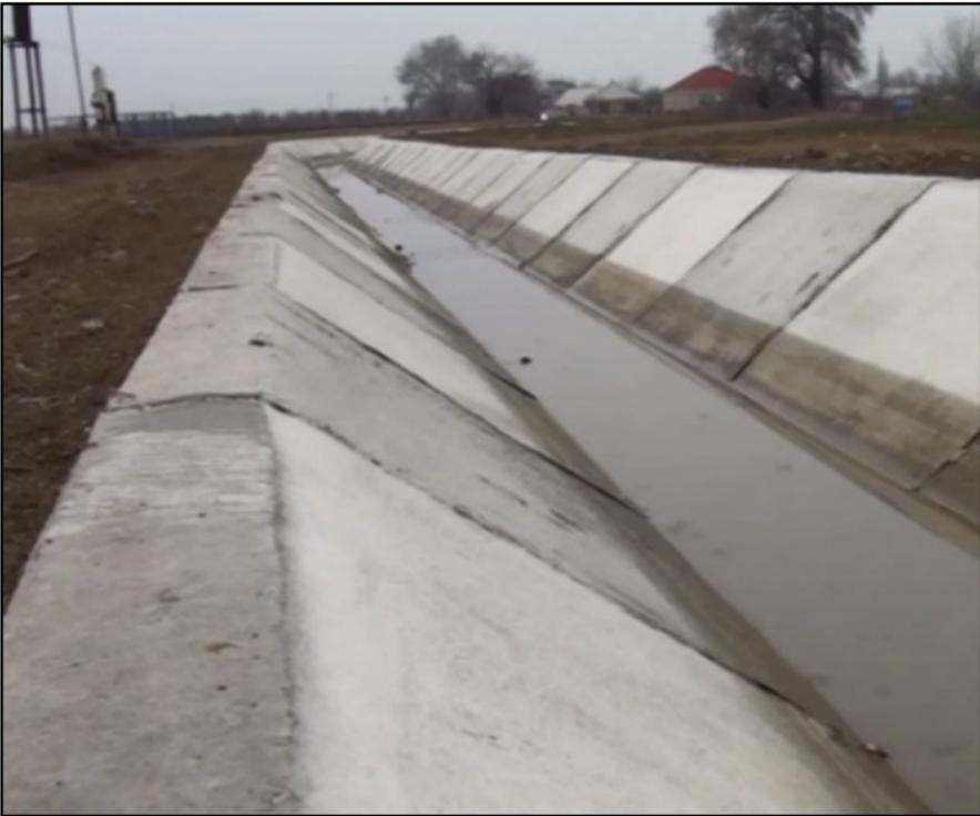
lənməsi nəzərdə tutulub. Qobu çay suvarma kanalının davamı olaraq 2,3 km torpaq məcralı Qandax kanalının 1 km uzunluğunda beton üzlüklə əvəzlənməsi və üzərindəki qurğularla birlikdə təmir edilməsi planlaşdırılıb. Hazırda kanalda işlər sürətlə davam edir.
